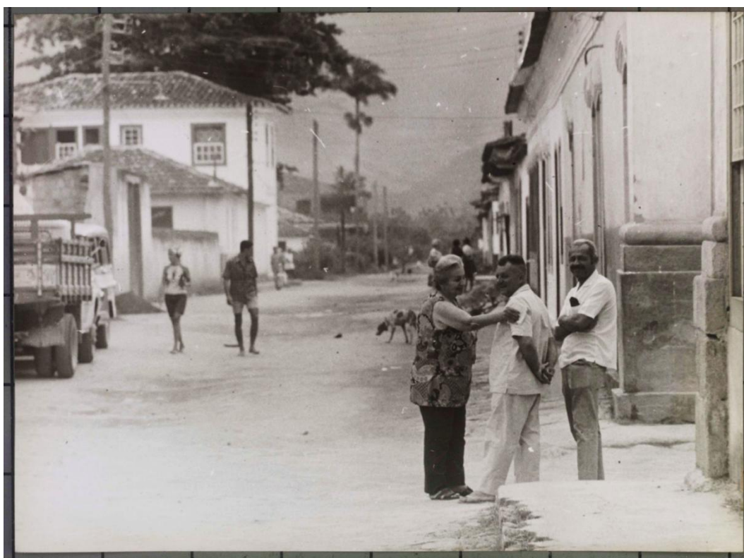
PARATY – RUA DA CADEIA (ATUAL RUA MARECHAL DEODORO).
